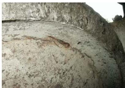
Rys. 4. Pęknięcia dna po obwodzie Fig. 4. Circumferential crack in the ladle bottom
