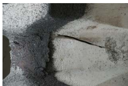
Rys. 2. Pęknięcie ścianki kadzi Fig. 2. Crack in the ladle wall
