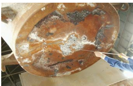
Rys. 3. Pęknięcie wzdłużne dna kadzi Fig. 3. Lengthwise crack in the ladle bottom
